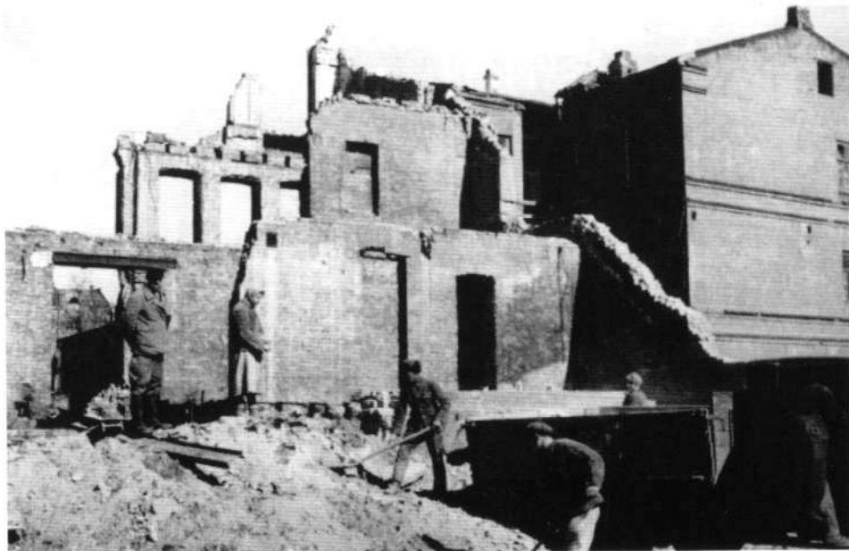
Разрушенное здание физмата РГУ на улице Горького. Из архива автора
