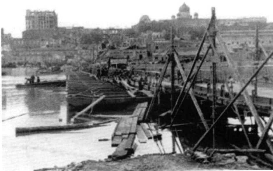
Немецкие саперы восстанавливают мост через Дон. Из архива В. Борзенко
